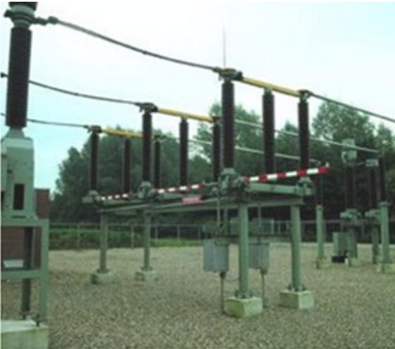
*Seccionadores de columnas giratorias.*
