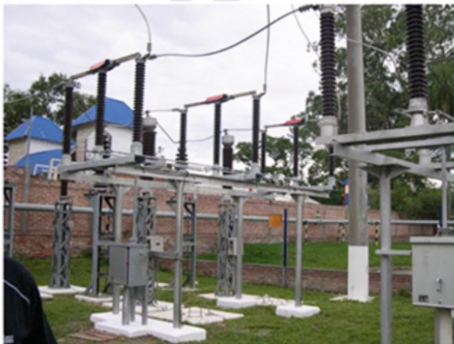
Seccionadores de cuchillas deslizantes montados en intemperie.
